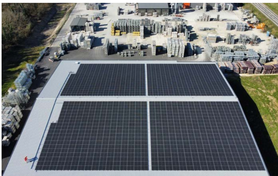
Le nouveau bâtiment de notre plateforme logistique de Saint-Genix-les-Villages est équipé de 3 500 m 2 de panneaux photovoltaïques.
