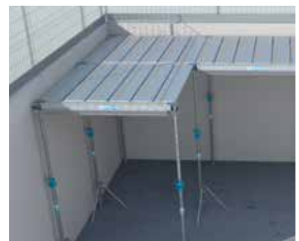
Les poutrelles extensibles permettent de se rapprocher des bords de la cellule
